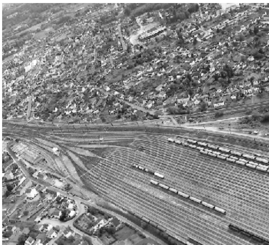
Un nouvel avenir s'ouvre pour l'ancienne « gare de triage ».
